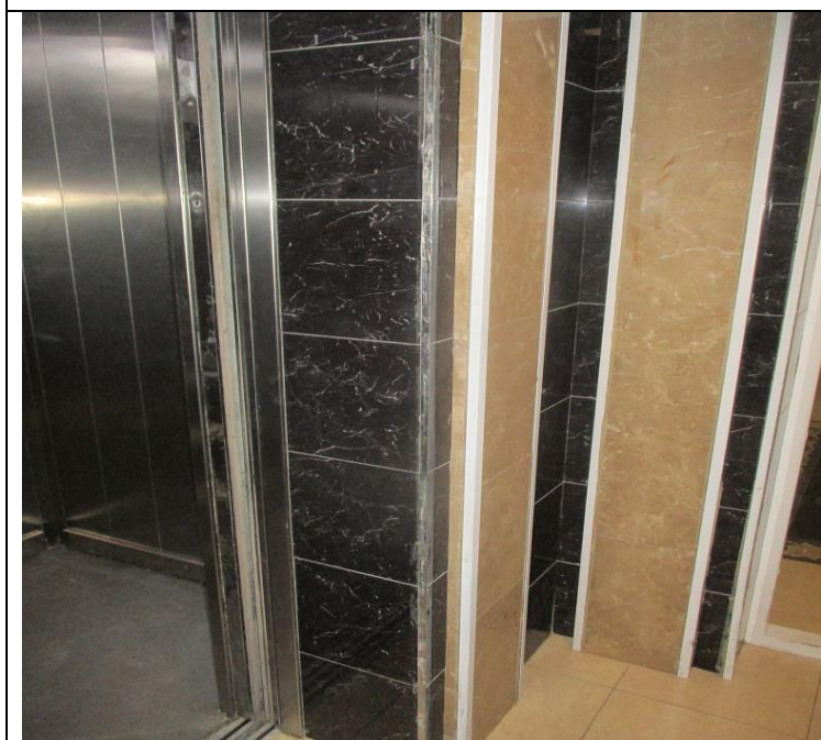
Кор.3 эт.-1 Лифтовый холл Установка защитного уголка -установка уголка
