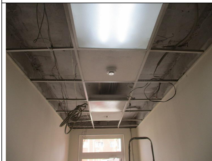
Кор.3, эт.2 Коридор Замена потолочных плит -установка потолочной плитки
