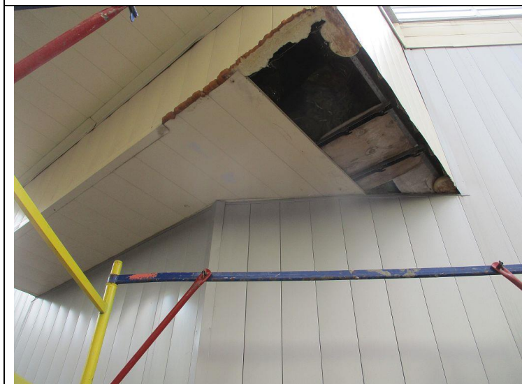
Кор.5, Сек.1, эт.-2 Холодный проезд Установка реечного потолка -установка реечного потолка
